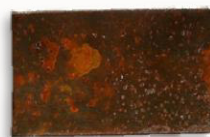
Внутренняя поверхность образцов труб после проведения коррозионных испытаний
